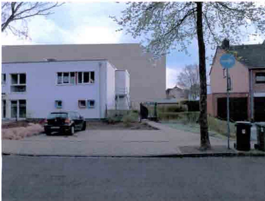
Leitgraben 8, Blickrichtung Süd
