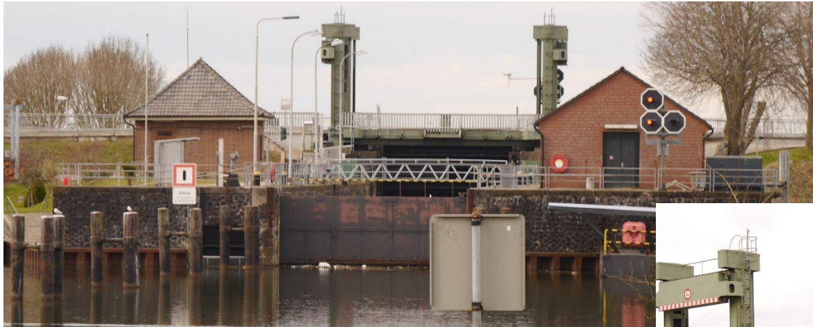
Schleuseneinfahrt ins Oberhaupt
