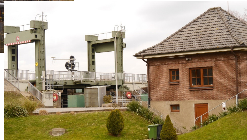
Hubbrücke über Schleuse und Betriebsgebäude
