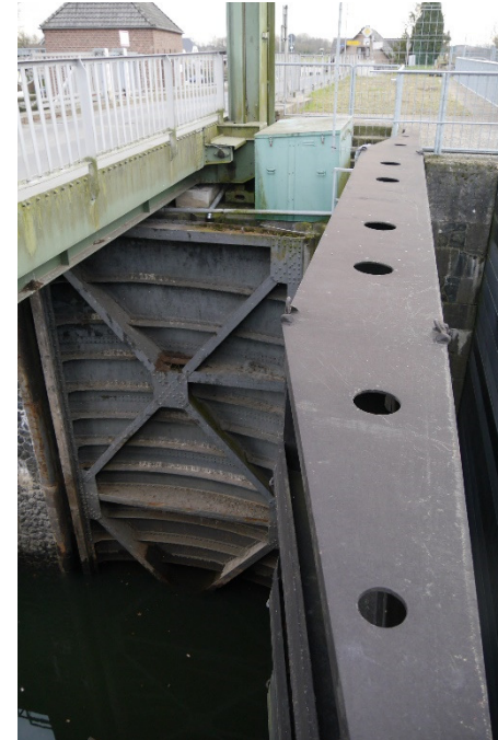
Schleusenunterhaupt mit Dammbalkenverschluss zum HWS
