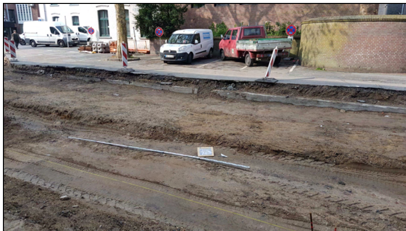
Abbildung 10: Übersichtsfoto Arbeitsbereich Stelle 7, Abschnitt Nord, von Osten gesehen. Am Rand des Planums eine frühere Straßen- bzw. Wegebegrenzung. (Quelle: WAB 2017)
