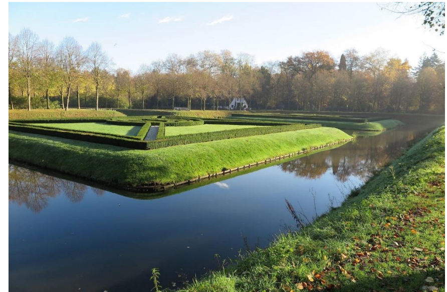
Abb. 36 Die beiden Kanalinseln des Prinz-Moritz-Kanals
