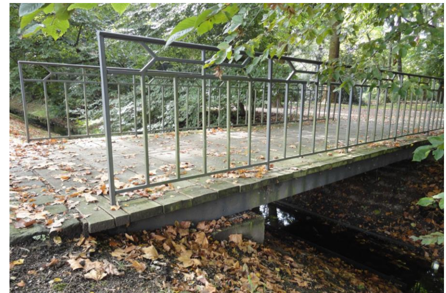
Abb. 43 Holzbrücke und Geländer am Forstgarten als Grundmodell
