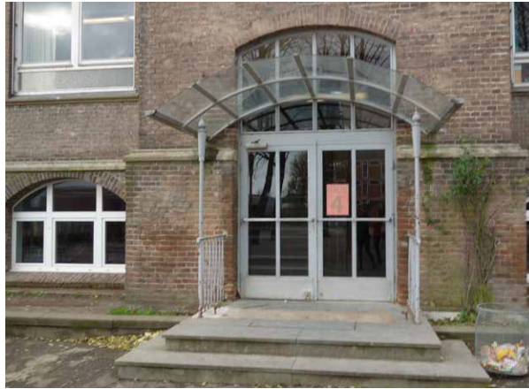
Schulhofseitiger Eingang zu Haus 4
