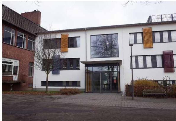
Zugang zu Haus 3
