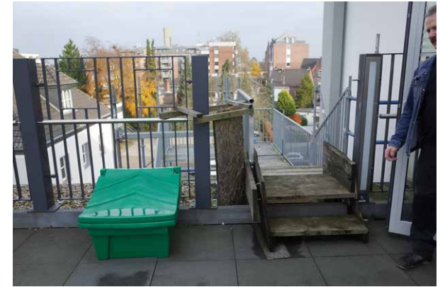
Zugang provisorisches Fluchttreppenhaus
