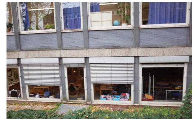
Blick auf Hauswirtschaftsräume
