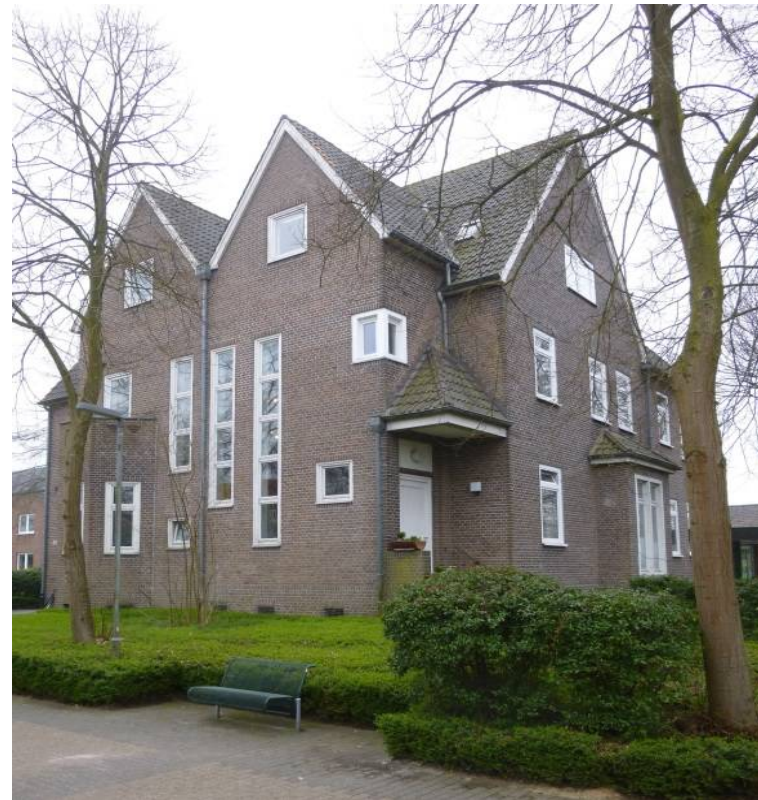
Haus Riswick (Verwaltungsgebäude/Villa)
