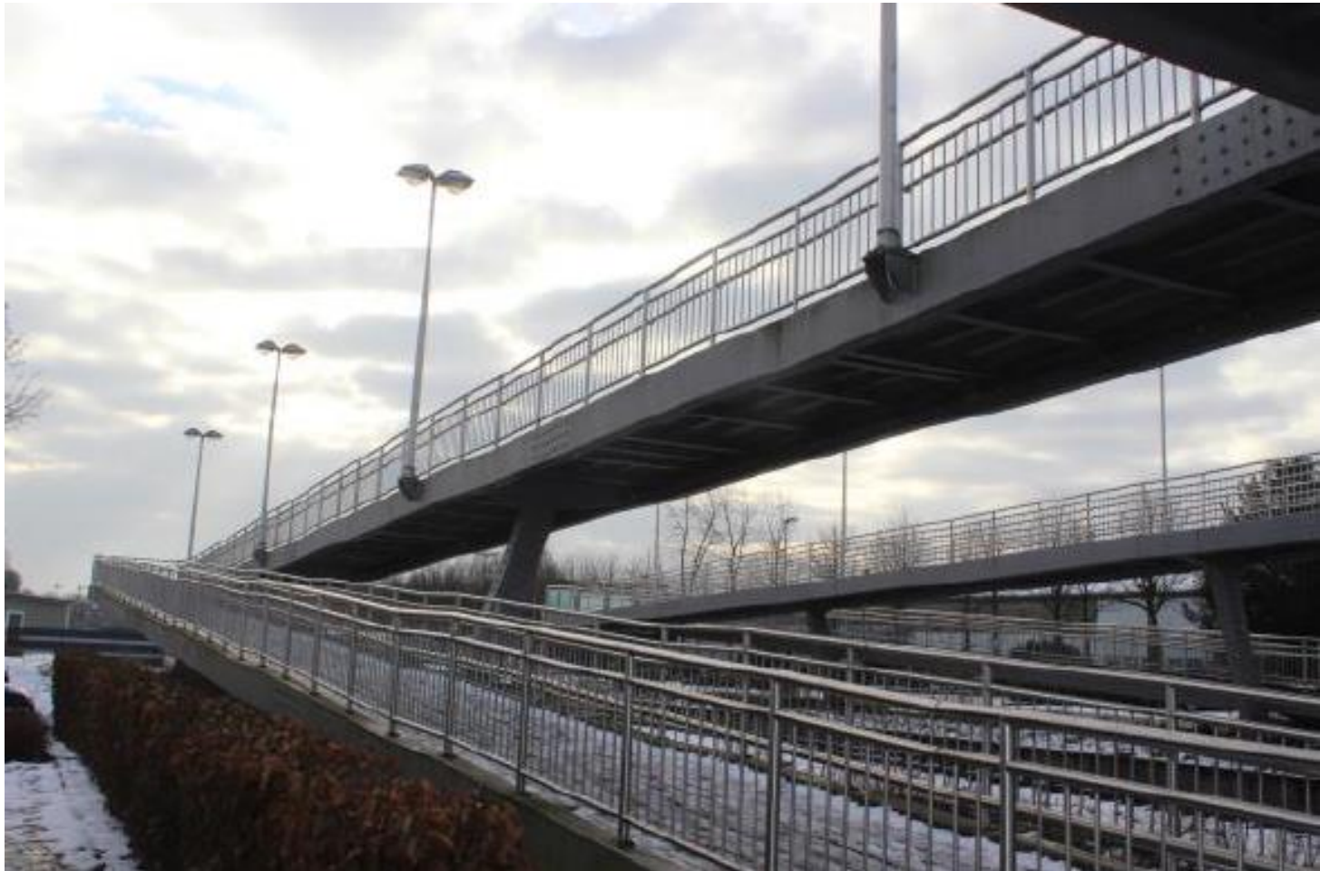
Variante 3: Rampe an bestehendem Brückenbauwerk, Bahnhof Kevelaer
