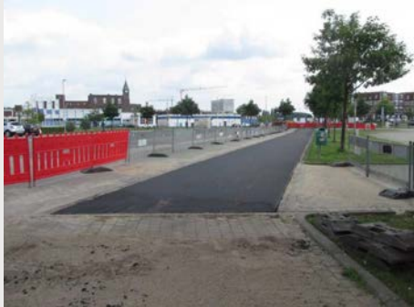
1. Bauabschnitt Wiesenstraße – Flutstraße Querung Wiesenstraße und Radwegführung Kirmesplatz
