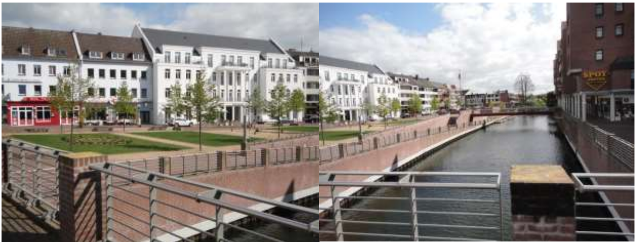
Abbildung 1 Blick auf den Opschlag
