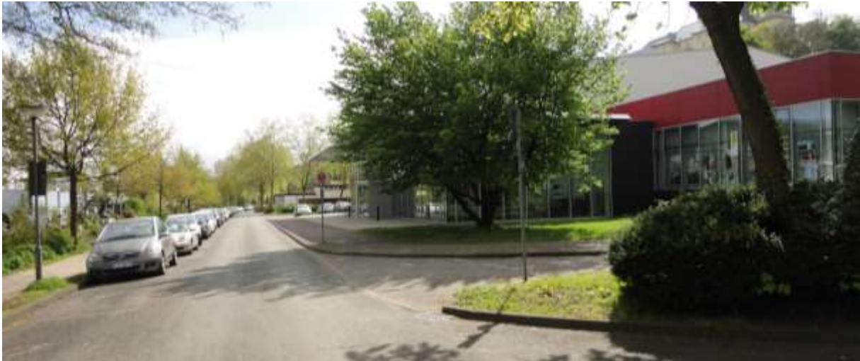
Abbildung 5 Blick vom Bleichen auf die Stadthalle
