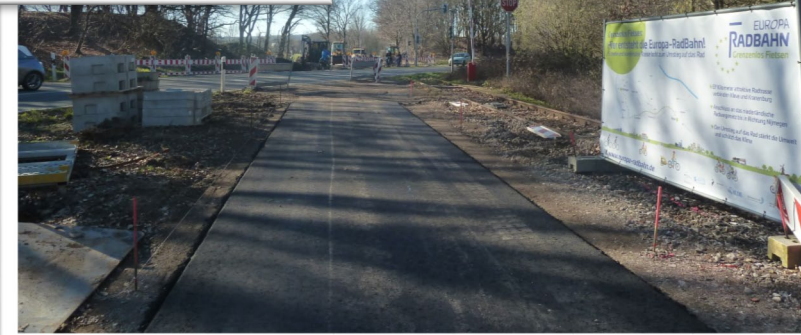
Europa-RadBahn Kleve - Kranenburg 2.Bauabschnitt Kranenburg
