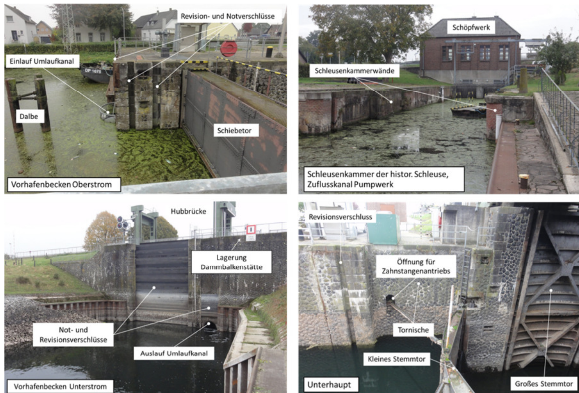
Abbildung 6: Ausgewählte Bilder der Schleuse Brienen (Quelle: BCE, 2016)
