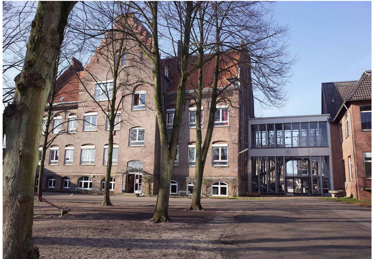
Schulhofseitiger Blick auf Haus 4 mit gläsernem Foyer
