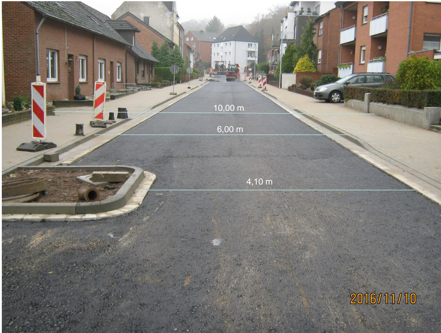
Längsparkstreifen In Asphaltbauweise
