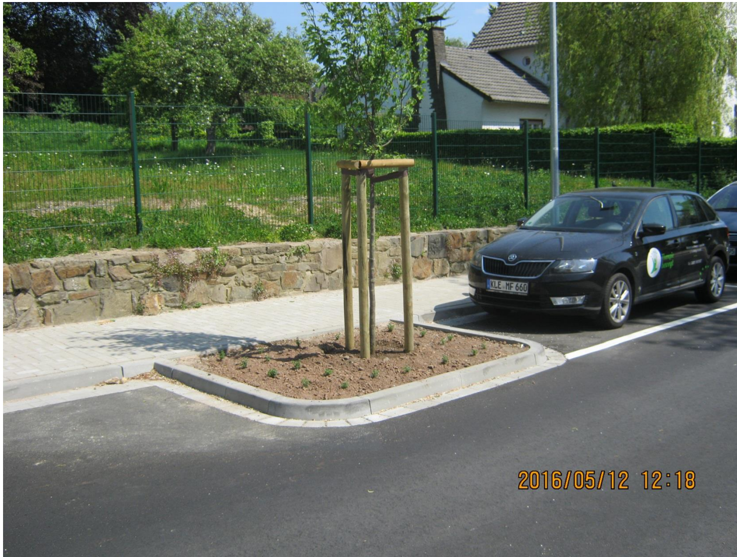
Längsparkstreifen In Asphaltbauweise
