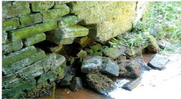
Fußbereich Widerlagerwand Süd am Ausgang West
