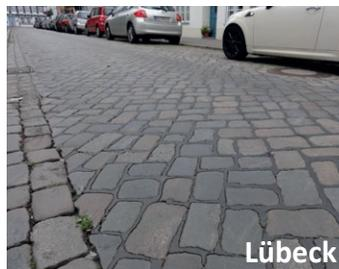
Die Bilder zeigen die unterschiedlichen technischen Möglichkeiten zur Herstellung erschütterungsärmerer Strukturen in städtebaulich sensiblen Bereichen auf: Schaffung eines „Komfort“-Streifens (Speyer), Verwendung eines abgeschliffenen Pflasters (Münster) sowie eine nachträgliche Fugenverfüllung (Lübeck).
