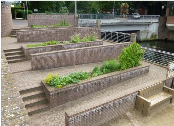
Abbildung 14: Treppen-/Rampenanlage am Spoykanal-Ufer
