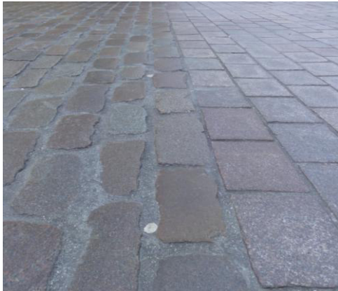
Abbildung 38: Abgeschliffenes Pflaster in Münster
